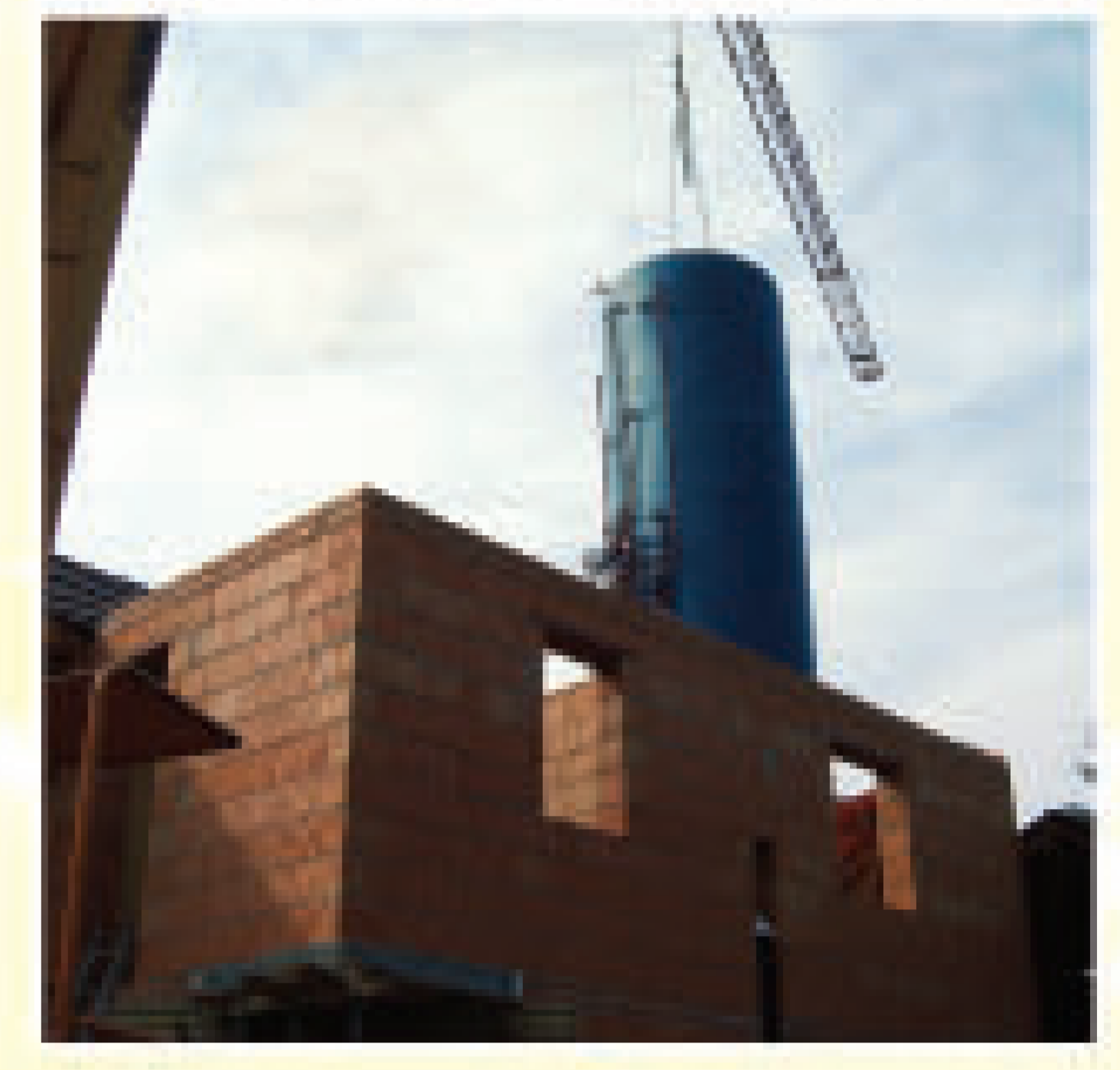
Anhebung und Ausbau des Dachstuhls, Einbau eines Großpufferspeichers in Kombination mit einem Niedertemperatur-Flächenheizsystem und 48 m 2 Kollektoren.
