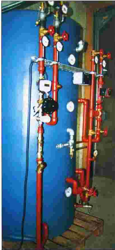
Im Labor wird eine Fernheizungs-Hausstation ausgemessen und optimiert.
